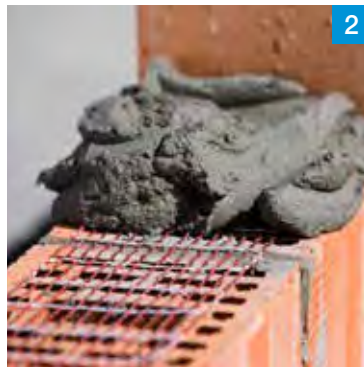
2 Apply a layer of mortar.
